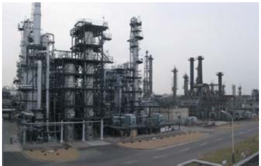
水島製油所でのガソリンのサルファーフリー設備
