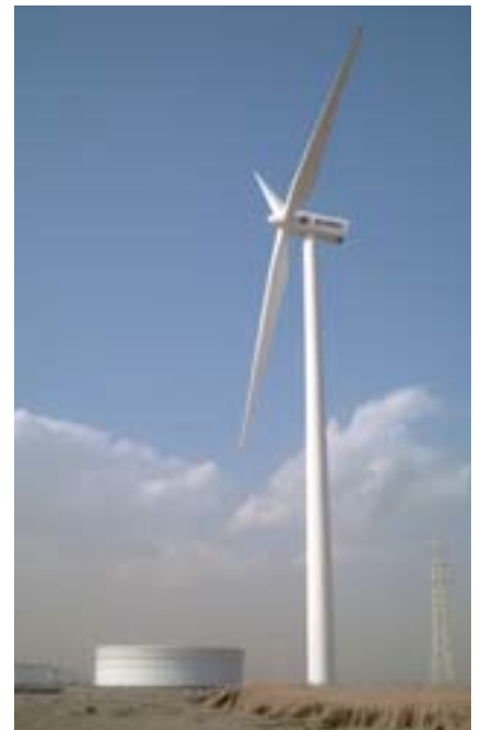
鹿島製油所内の風力発電設備
