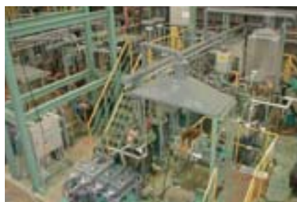
湿式銅製錬パイロット試験設備
